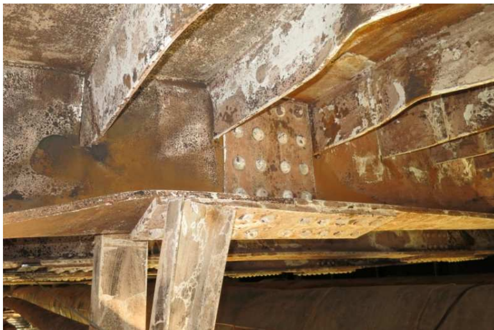
Rys. 11. Przęsło nr 10–11. Skręcenie poprzecznic i duże odkształcenia podłużnic
