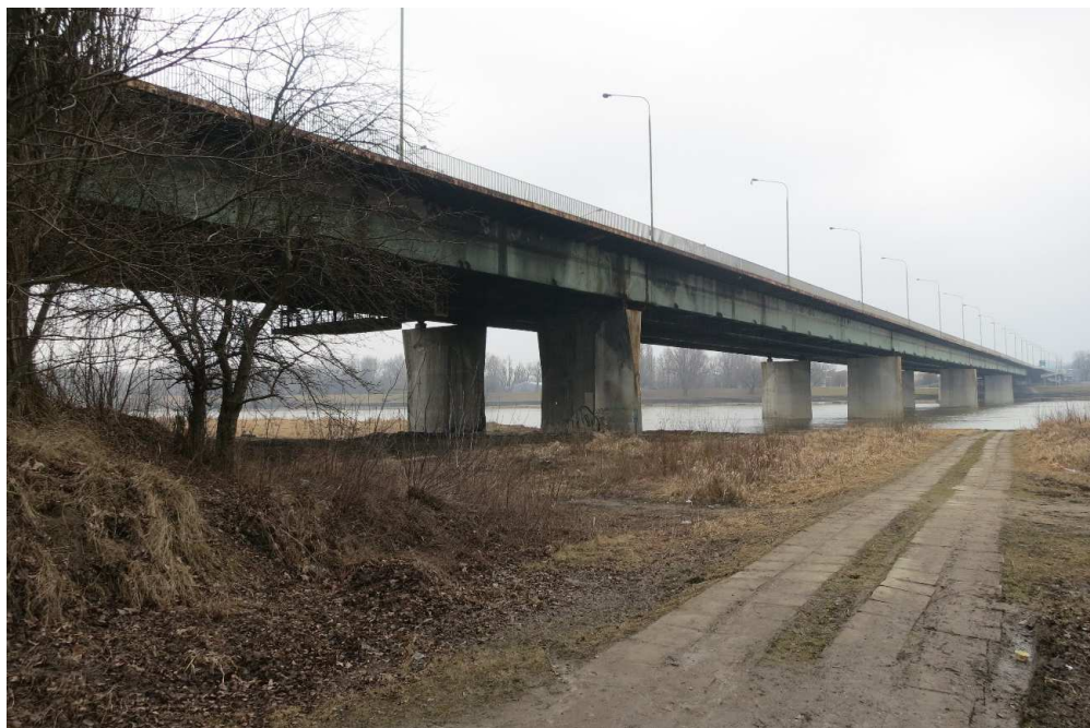
Rys. 3. Widok mostu od strony północnej
