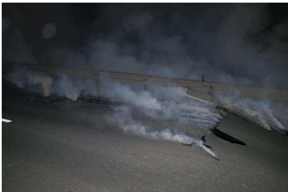
Rys. 5. Nawierzchnia mostu w trakcie pożaru
